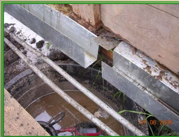
Sistem oluka za sakupljanje procedne tečnosti
