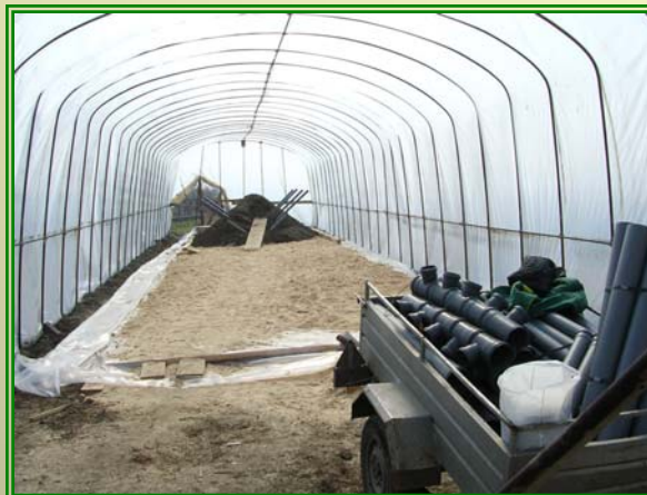
Postavljanje cevi za aeraciju
