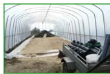
Postavljanje cevi za aeraciju
