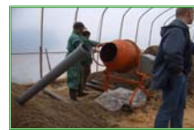
Mešanje zemlje pre nanošenja na haldu
