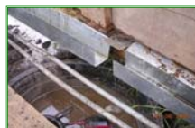
Sistem oluka za sakupljanje procedne tečnosti
